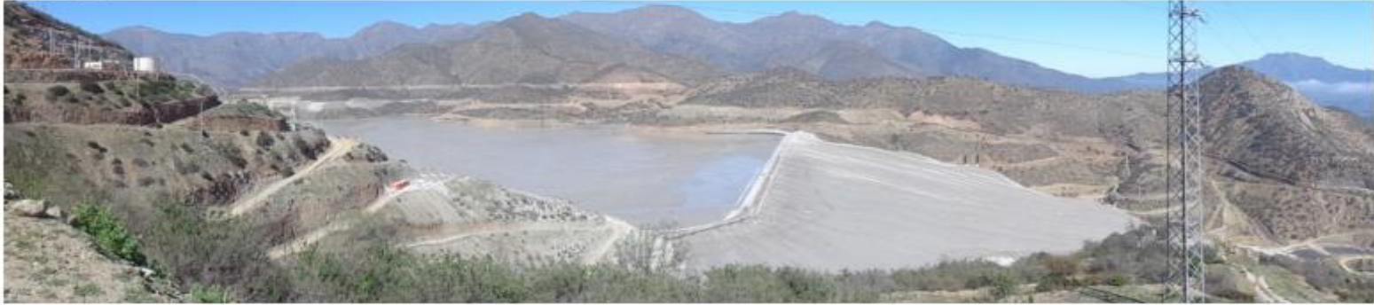
Muro de arenas
