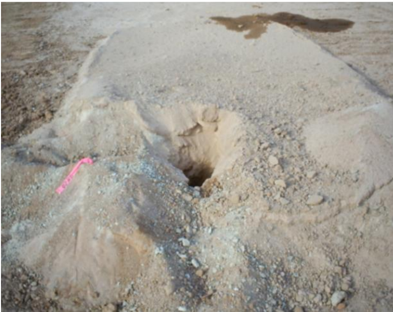
Pozo de tronadura
